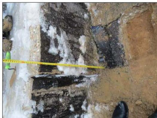
ФОТО 6. Уточнение толщины фундаментной плиты шурфа №2 расположенного в осях В/8-1/16
