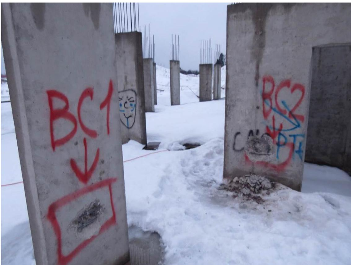
**Рис. 3.2.3. Общий вид вскрытий монолитной ж.б. конструкций стены лестничной клетки и пилона выше отм. ±0,000 мм**
