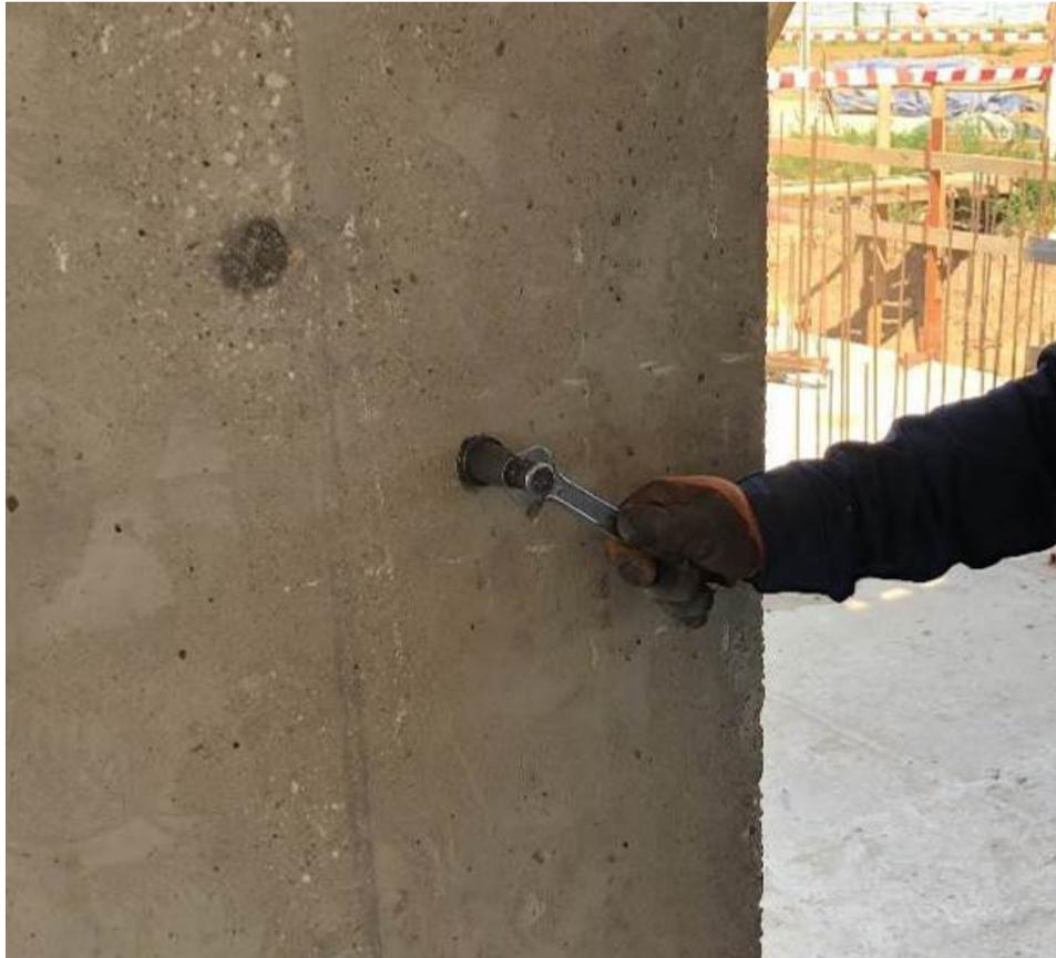
**Рис. 4.2.3. Установка анкерного устройства и тяги в отверстии монолитного пилона 1-го этажа в/о В/9//1/11-1/14**
