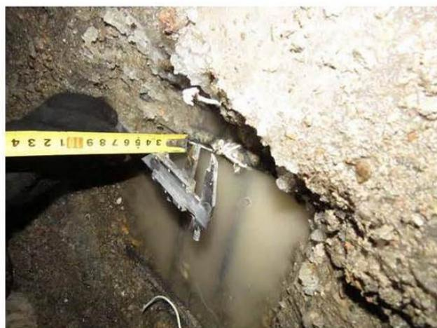
**ФОТО 16.** Замер толщины защитного слоя бетона плиты подвала на отм. выше 0.000 по оси А/4 между осями 1/11-1/14 (зона верхнего армирования)
