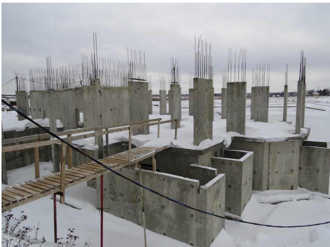
**Рис. 3.2.1. Общий вид монолитных ж.б. колонн и пилонов на отм ±0,000 м**
