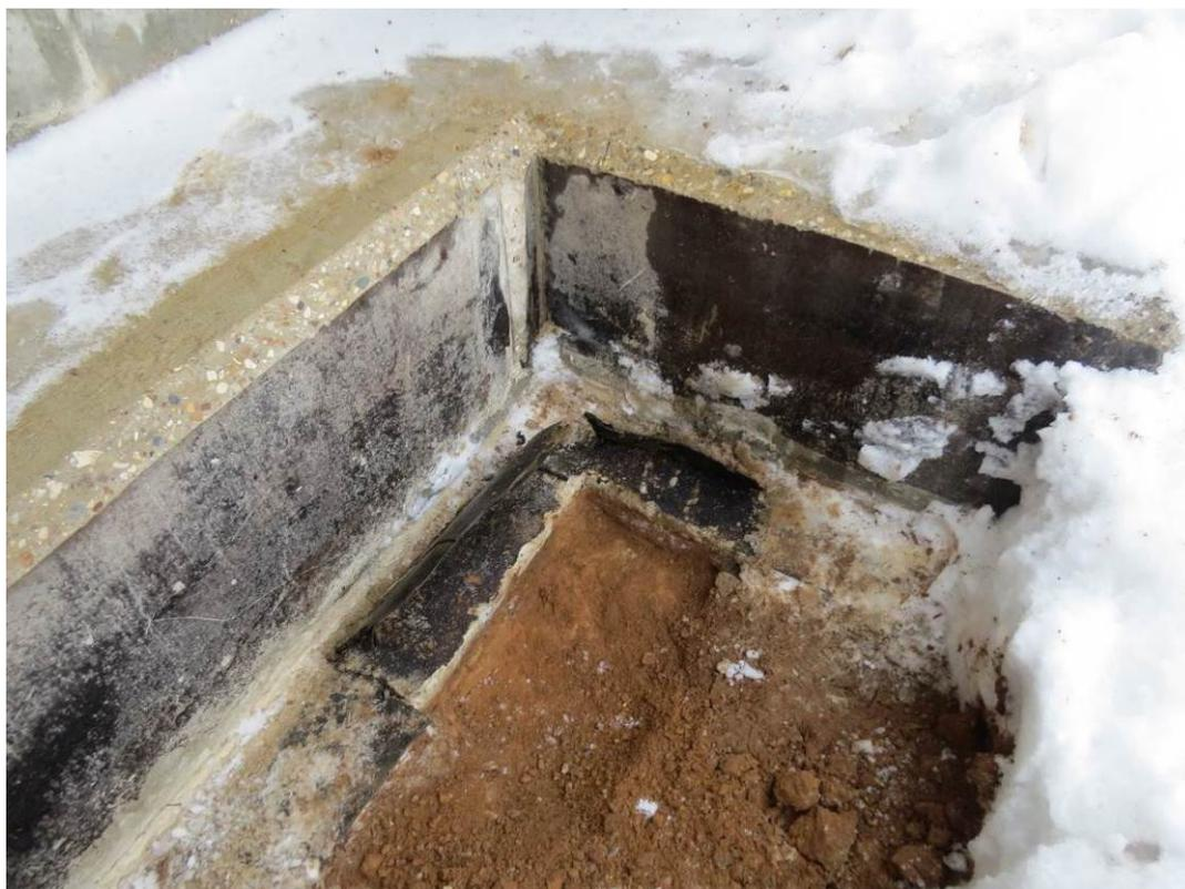
**Рис. 3.1.1. Шурф №1 под наружную несущую монолитную ж.б. стену снаружи здания секция 2 между осями Б/5-Б/7 по оси 1/16**
