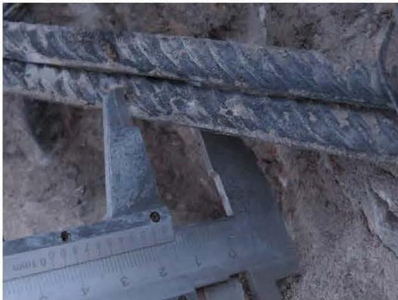
ФОТО 9. Замер диаметра вертикального армирования пилона на отм. выше ±0.000 этажа по оси А/4 между осями 1/11-1/14
