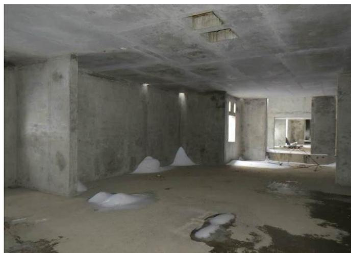
**Рис. 3.1.9. Проникновение воды в подвальное помещение в местах прохода коммуникаций и проемов наружных стен**
