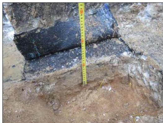
ФОТО 5. Уточнение толщины бетонной подготовки шурфа №2 расположенного в осях В/8-1/16
