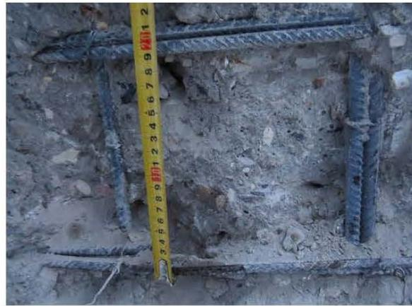
ФОТО 12. Общий вид вскрытия монолитной железобетонной стены на отм. выше ±0.000 между осями 1/8-1/11 и А/4-А/6 (горизонтальный шаг арматуры)
