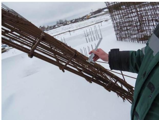
**Рис. 3.2.14. Поражение арматурных выпусков поверхностной коррозией**
