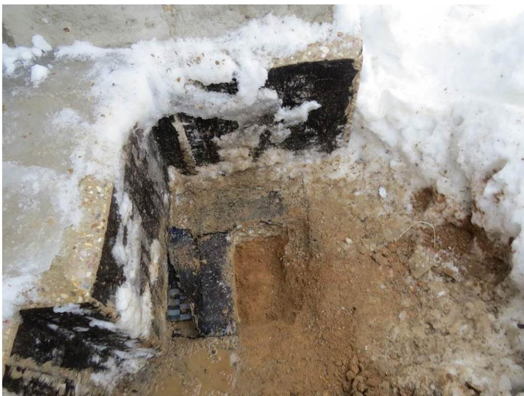
**Рис. 3.1.2. Шурф №2 под наружную несущую монолитную ж.б. стену снаружи здания секция 3 между осями В/8-В/9 рядом с осью 1/17**
