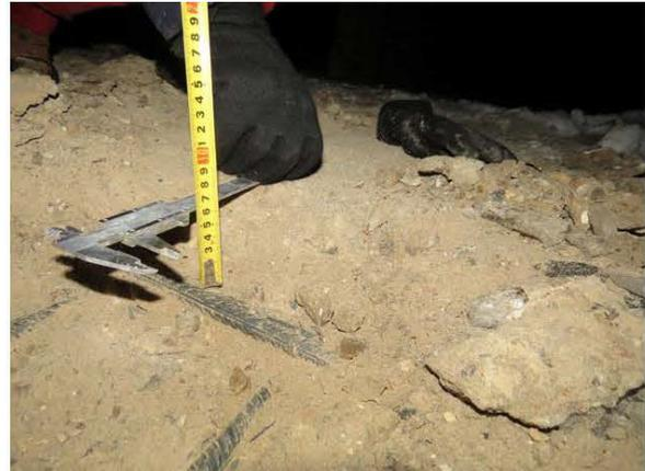
ФОТО 22. Замер толщины защитного слоя бетона плиты подвала на отм. ниже 0.000 по оси Б/5 между осями 1/8-1/11 (зона верхнего армирования)
