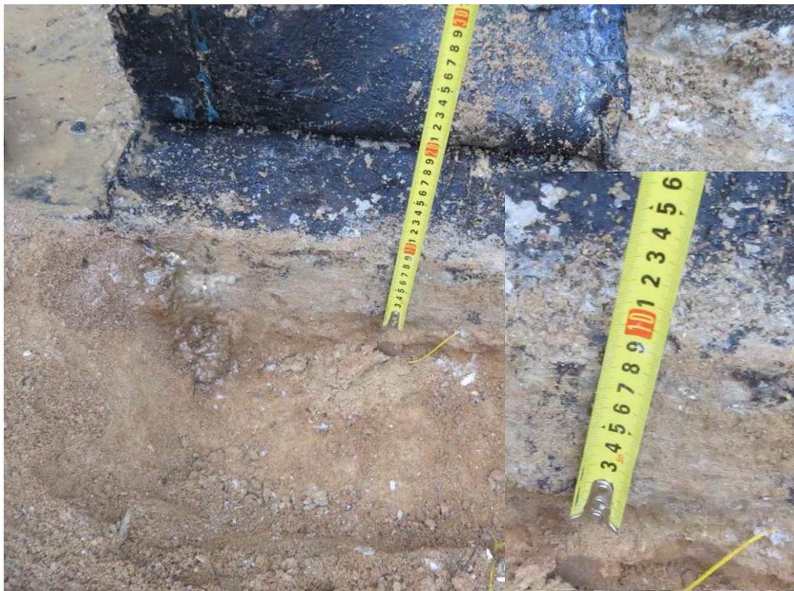
**Рис. 3.1.4. Замер толщины бетонной подготовки в отрытом шурфе №2 секция 3 между осями В/6-В/8 рядом с осью 1/17**
