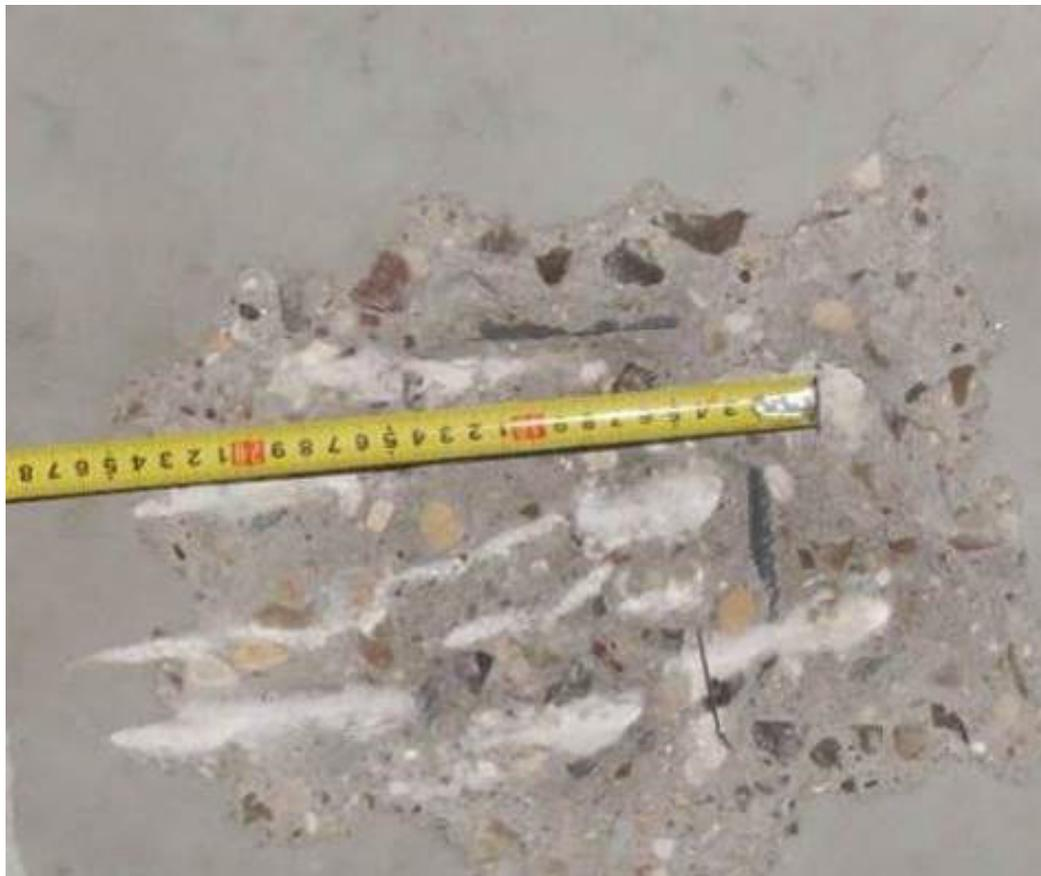
**Рис. 3.3.3. Общий вид участка вскрытия монолитной ж.б. плиты перекрытия между осями 1/11-1/14 и Б/3-Б/4 (зона нижнего армирования)**
