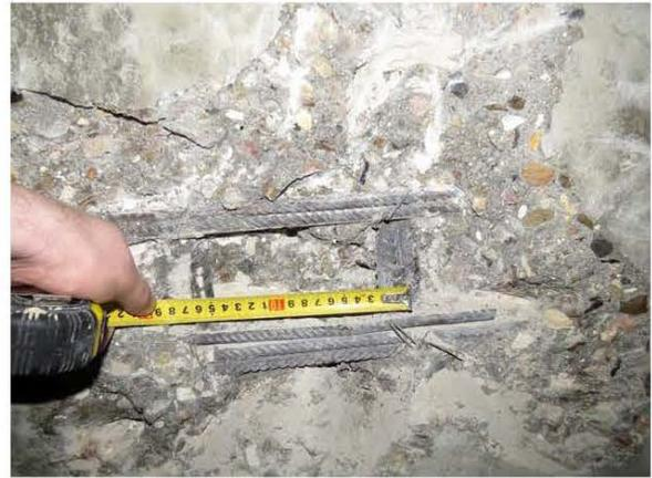
ФОТО 18. Уточнение диаметра арматуры монолитного железобетонного пилона на отм. ниже ±0.000 по оси Б/5 между осями 1/11-1/14 (вертикальный шаг арматуры)
