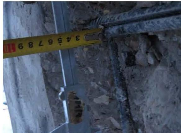
ФОТО 14. Замер толщины защитного слоя бетона стены на отм. выше ±0.000 между осями 1/8-1/11 и А/4-А/6
