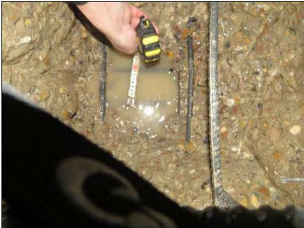
ФОТО 25.Общий вид участка вскрытия монолитной ж.б. плиты покрытия по осям А/1-А/2 между осей 1/11-1/14. Вертикальный шаг. (зона нижнего армирования)
