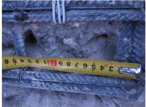
ФОТО 8. Общий вид вскрытия монолитного железобетонного пилона на отм. выше ±0.000 этажа по оси А/4 между осями 1/11-1/14 (вертикальный шаг арматуры)
