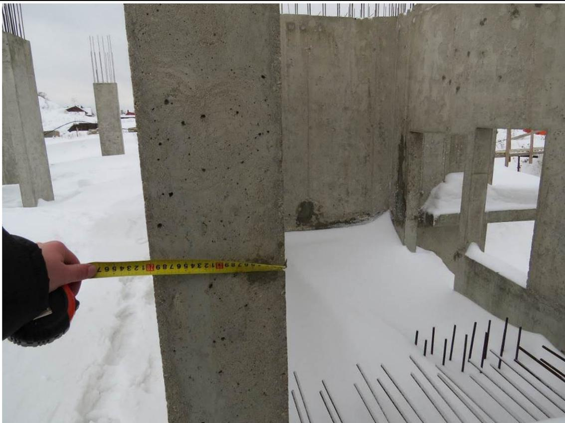
**Рис. 3.2.2. Замер толщины монолитной ж.б. стены лестничной клетки**
