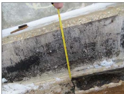
ФОТО 3. Уточнение толщины фундаментной плиты шурфа №1 расположенного в осях Б/5-Б/7 и 1/16
