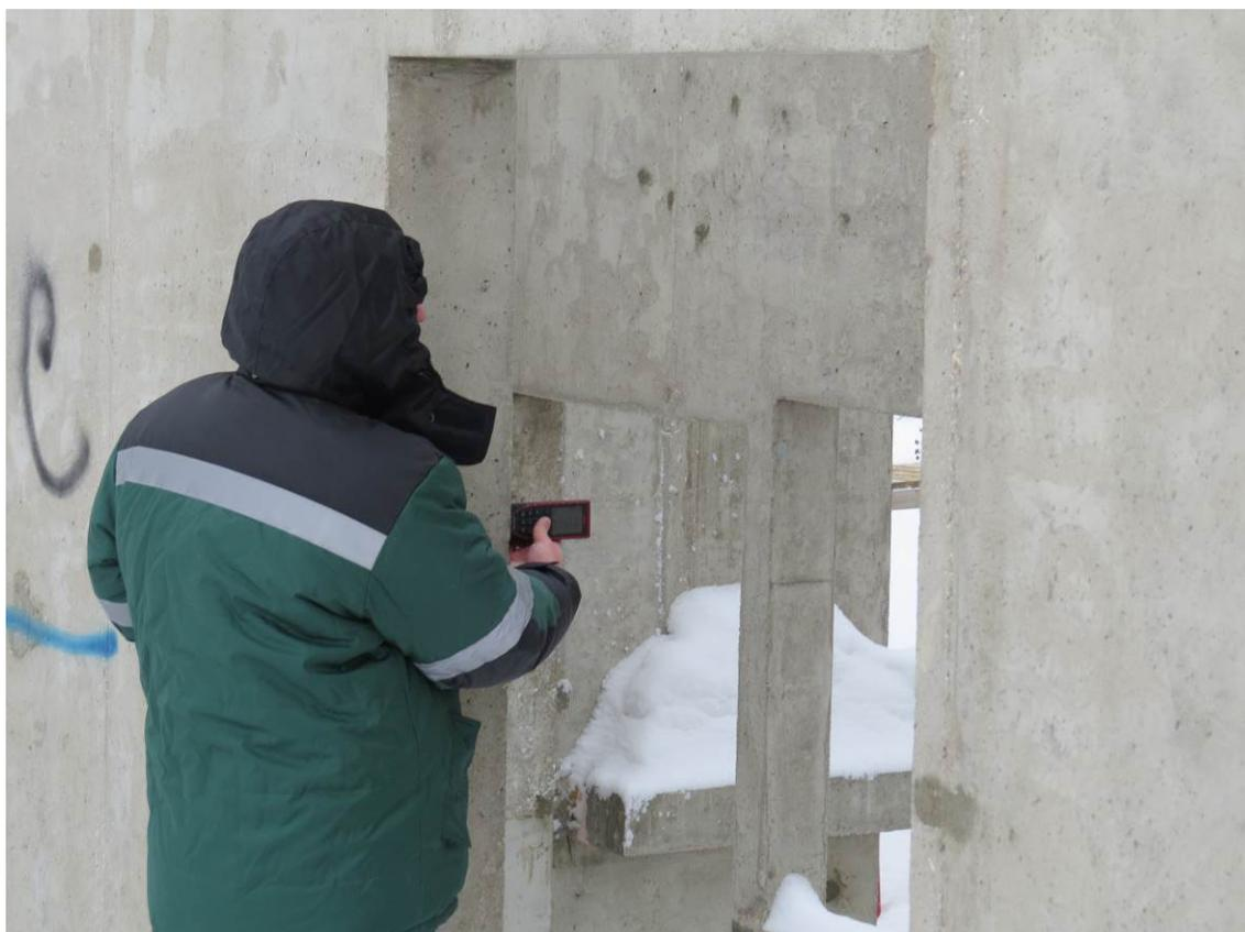
**Рис. 2.4. Уточнение габаритов лифтовой шахты в уровне 1 этажа этажа при помощи лазерного дальномера Leica DISTO D410**
