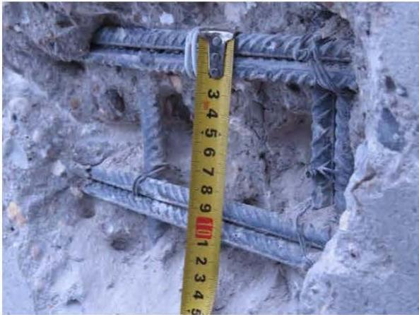
ФОТО 7. Общий вид вскрытия монолитного железобетонного пилона на отм. выше ±0.000 этажа по оси А/4 между осями 1/11-1/14 (горизонтальный шаг арматуры)
