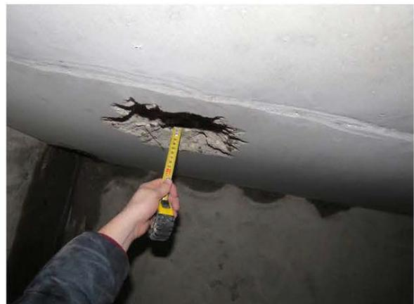
ФОТО 24. Замер толщины защитного слоя бетона плиты перекрытия между осями 1/11-1/14 и Б/3-Б/4 (зона нижнего армирования)
