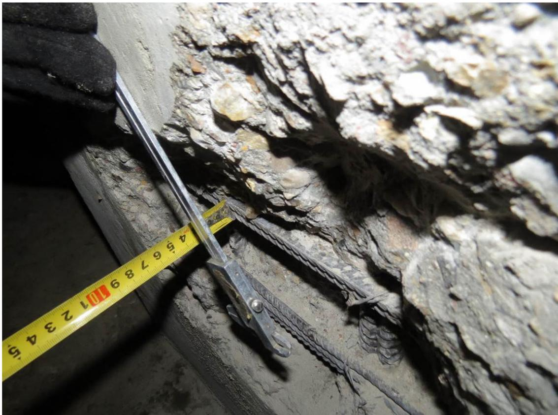
**Рис. 3.2.7. Замер толщины защитного слоя бетона пилона ниже отм.  $\pm 0,000$  мм**
