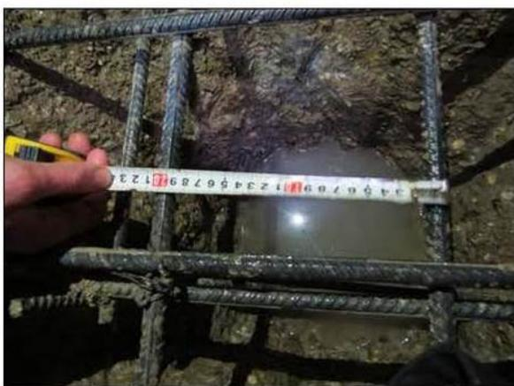
**ФОТО 28. Общий вид участка вскрытия монолитной ж.б. плиты подвала на отм. ниже 0.000 между осей А/1-А/2 и 1/11-1/14. Горизонтальный шаг. (зона верхнего армирования)**
