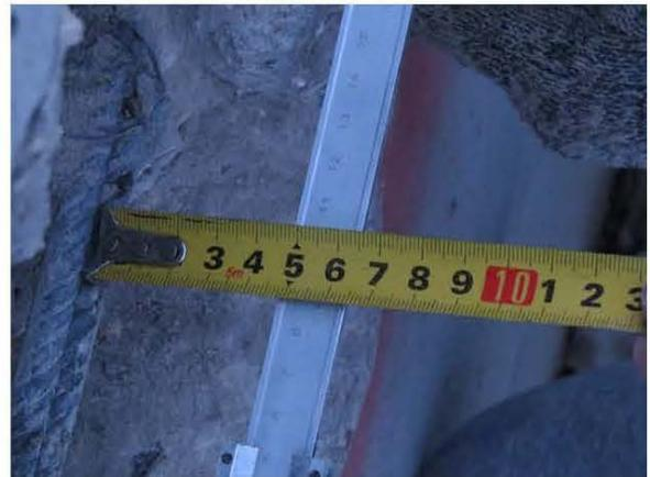
ФОТО 10. Замер толщины защитного слоя бетона пилона на отм. выше ±0.000 этажа по оси А/4 между осями 1/11-1/14
