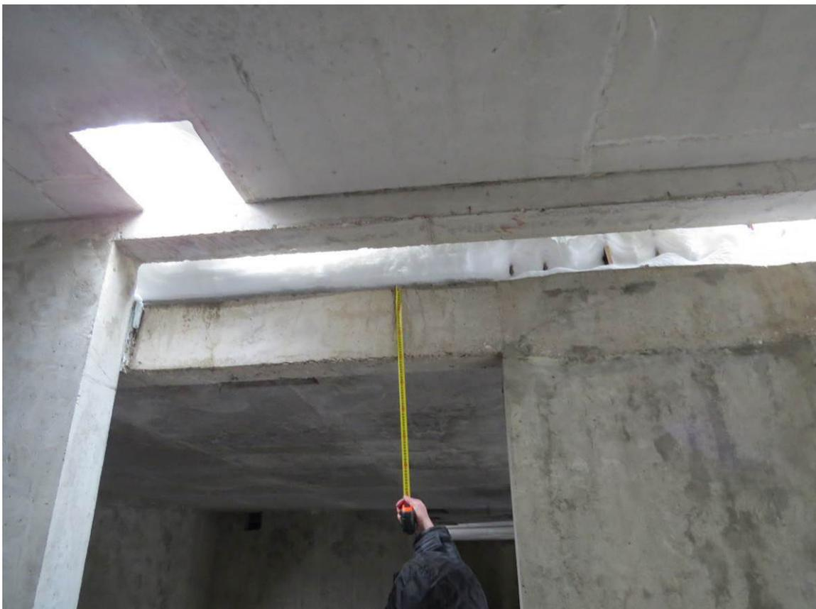
**Рис. 2.2. Замер толщины балки подвала по оси В/9 между осями 1/8-1/11**
