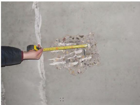
ФОТО 23. Общий вид участка вскрытия монолитной ж.б. плиты перекрытия между осями 1/11-1/14 и Б/3-Б/4 (зона нижнего армирования)
