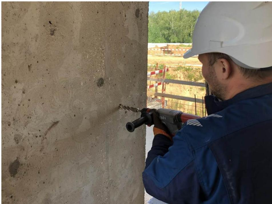
**Рис. 4.2.1. Сверление отверстия в монолитном пилоне 1-го этажа в/о В/9//1/11-1/14**
