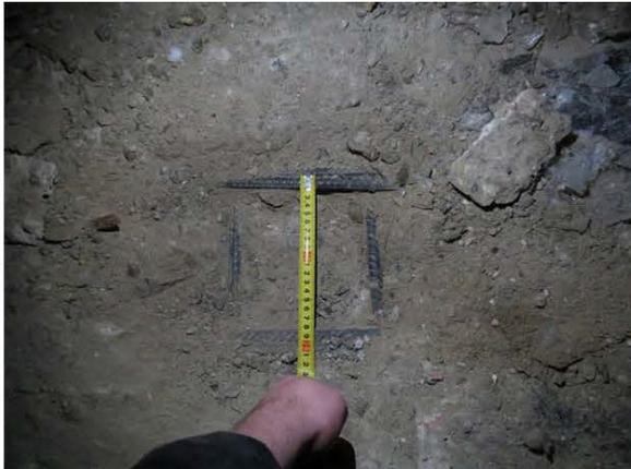
ФОТО 21. Общий вид участка вскрытия монолитной ж.б. плиты подвала на отм. ниже 0.000 по оси Б/5 между осями 1/8-1/11 (зона верхнего армирования)
