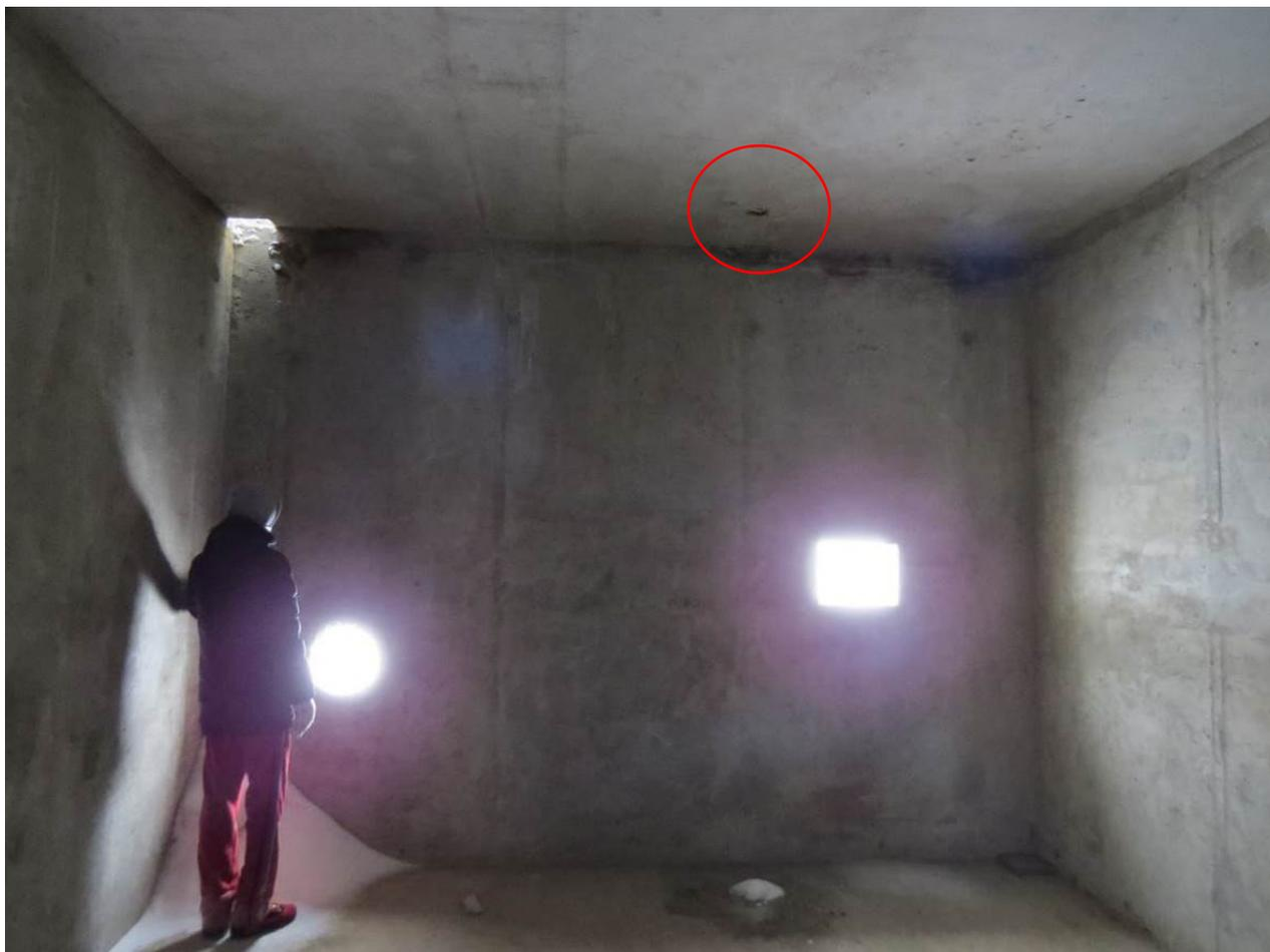
**Рис. 3.3.10. Непроектное сквозное отверстие в плите перекрытия расположенное по оси 2 между осями Г/5-Г/6**
