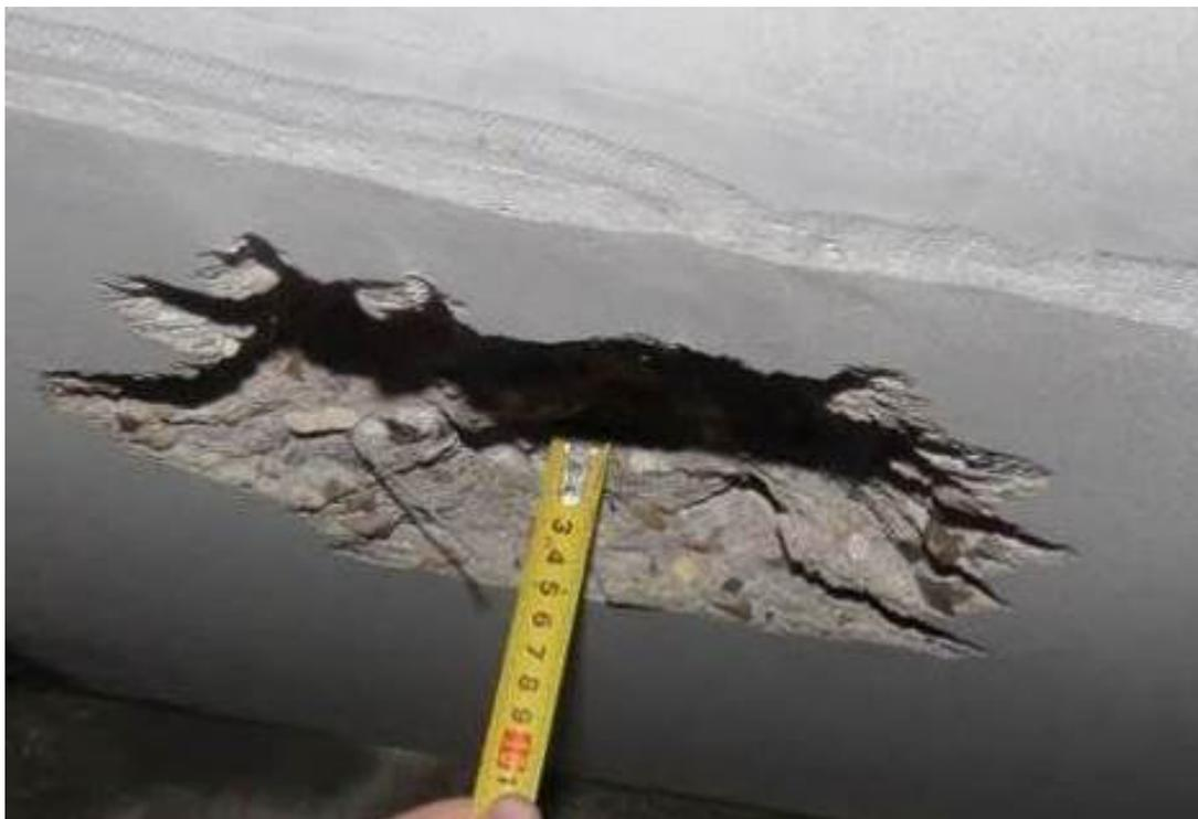
**Рис. 3.3.4. Замер толщины защитного слоя бетона плиты перекрытия подвала между осями 1/11-1/14 и Б/3-Б/4 (зона нижнего армирования)**
