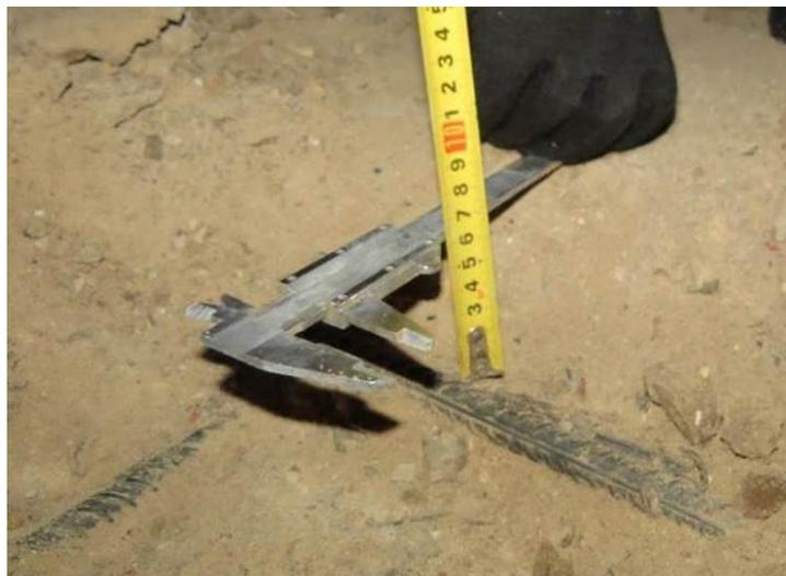
**Рис. 3.1.8. Определение толщины защитного слоя бетона верхней зоны армирования фундаментной плиты на участке вскрытия в секции 2 по оси Б/5 между осями 1/8-1/11**
