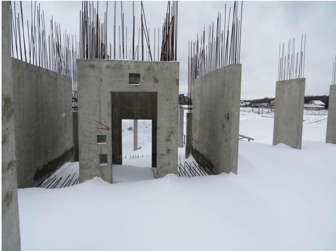
**Рис. 1.5. Общий вид смонтированных конструкций лестнично-лифтового узла в уровне первого этажа в осях В/3-В/5 и 1/4-1/8 жилого дома №63**
