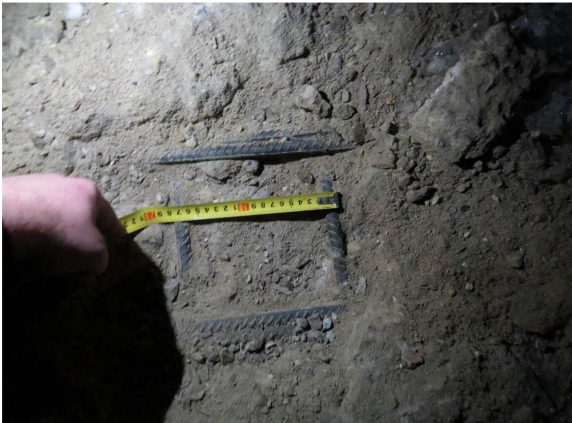
**Рис. 3.1.6. Замер шага продольных стержней вдоль цифровых осей верхней зоны армирования фундаментной плиты на участке вскрытия по оси Б/5 между осями 1/8-1/11**
