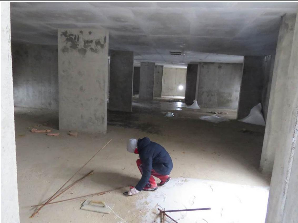
**Рис. 2.3. Замер высоты помещений подвального этажа при помощи лазерного дальномера Leica DISTO D410**
