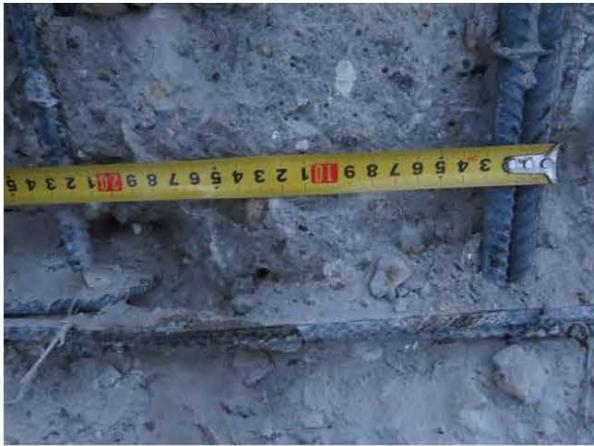
ФОТО 11. Общий вид вскрытия монолитной железобетонной стены на отм. выше ±0.000 между осями 1/8-1/11 и А/4-А/6 (вертикальный шаг арматуры)
