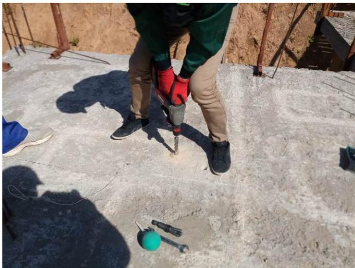
**Рис. 4.2.5. Сверление отверстия в монолитной плите перекрытия подвала в/о Г/6-Г/8/1/15-1/17**
