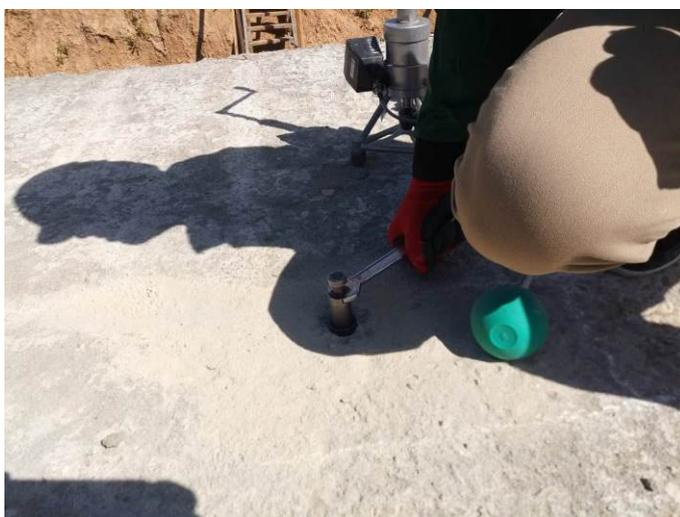
**Рис. 4.2.6. Установка анкерного устройства и тяги в отверстие монолитной плиты перекрытия подвала в/о Г/6-Г/8/1/15-1/17**
