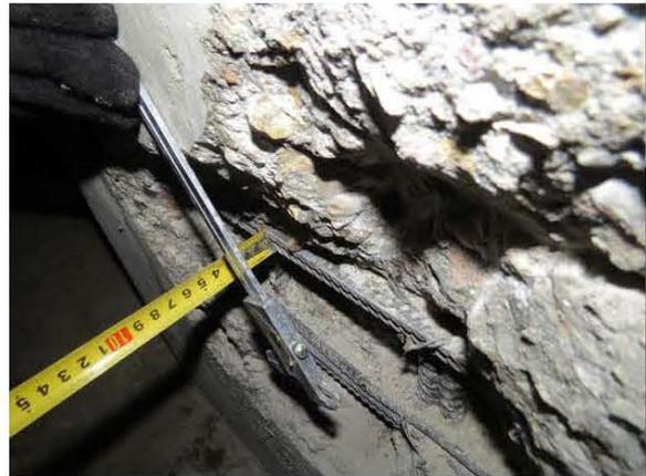
ФОТО 20. Замер толщины защитного слоя бетона пилона на отм. ниже ±0.000 по оси Б/5 между осями 1/11-1/14
