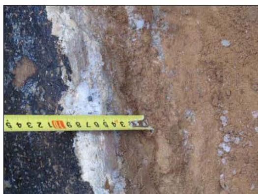
ФОТО 2. Уточнение толщины бетонной подготовки шурфа №1 расположенного в осях Б/5-Б/7 и 1/16
