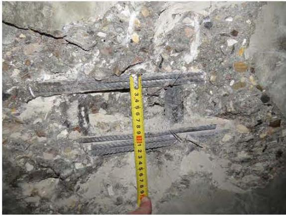
ФОТО 17. Общий вид вскрытия монолитного железобетонного пилона на отм. ниже ±0.000 по оси Б/5 между осями 1/11-1/14 (горизонтальный шаг арматуры)
