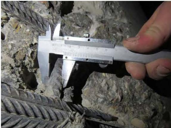
ФОТО 19. Замер диаметра вертикального армирования пилона на отм. ниже ±0.000 по оси Б/5 между осями 1/11-1/14
