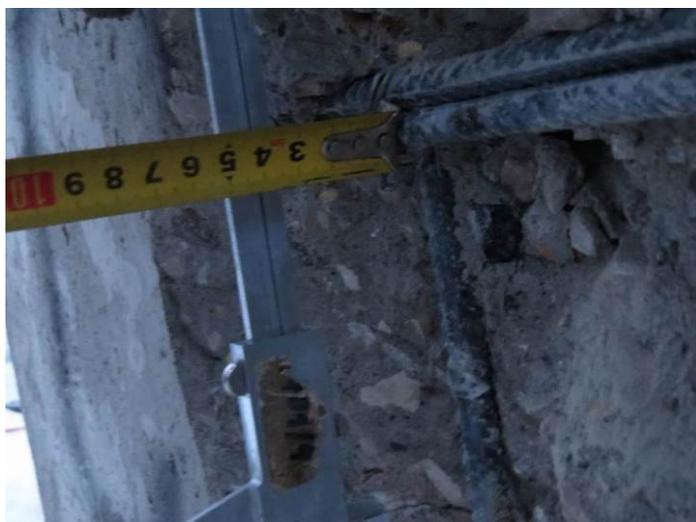
**Рис. 3.2.13. Замер толщины защитного слоя бетона монолитной ж.б. стены выше отм. ±0,000 мм**
