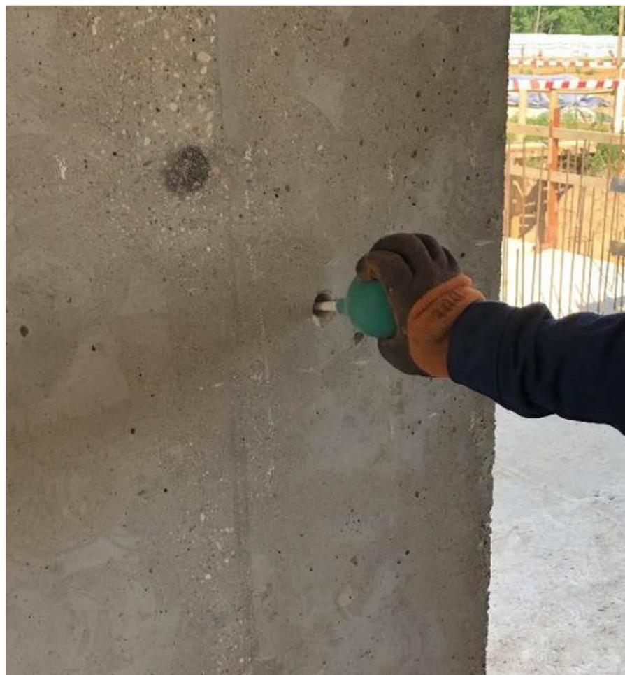
**Рис. 4.2.2 Продувка отверстия от пыли в монолитном пилоне 1-го этажа в/о В/9//1/11-1/14**
