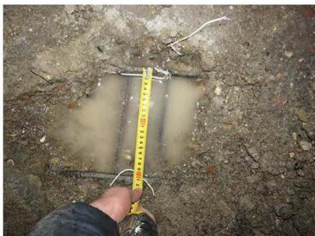
**ФОТО 15.** Общий вид участка вскрытия монолитной ж.б. плиты подвала на отм. выше 0.000 по оси А/4 между осями 1/11-1/14 (зона верхнего армирования)
