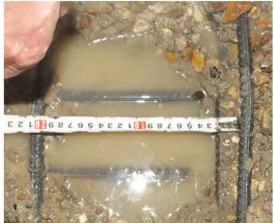
ФОТО 26. Общий вид вскрытия монолитной железобетонной плиты перекрытия подвала на отм. ниже ±0.000 по осям А/1-А/2 между осей 1/11-1/14 (горизонтальный шаг, нижней сетки армирования)
